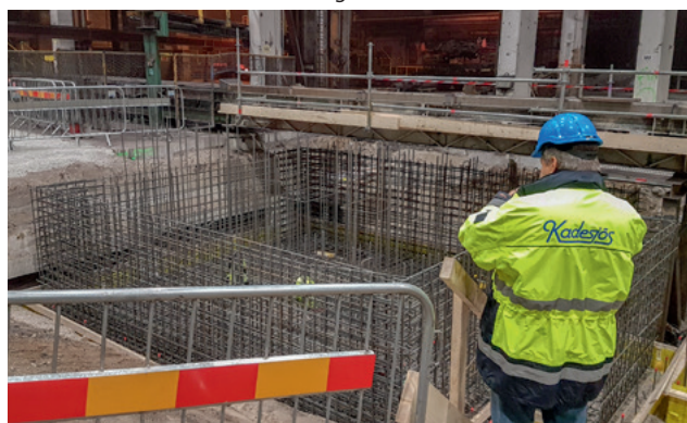
Antti Dahlvik som har hand om bygglösningen ser över armeringen i ett härvelfundament.
