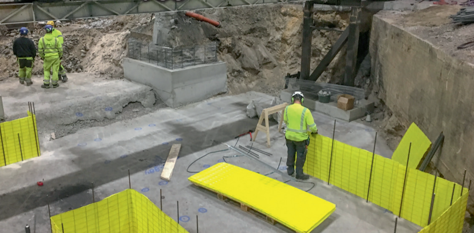
Formning av valsfundament där kvarsittande form används.
