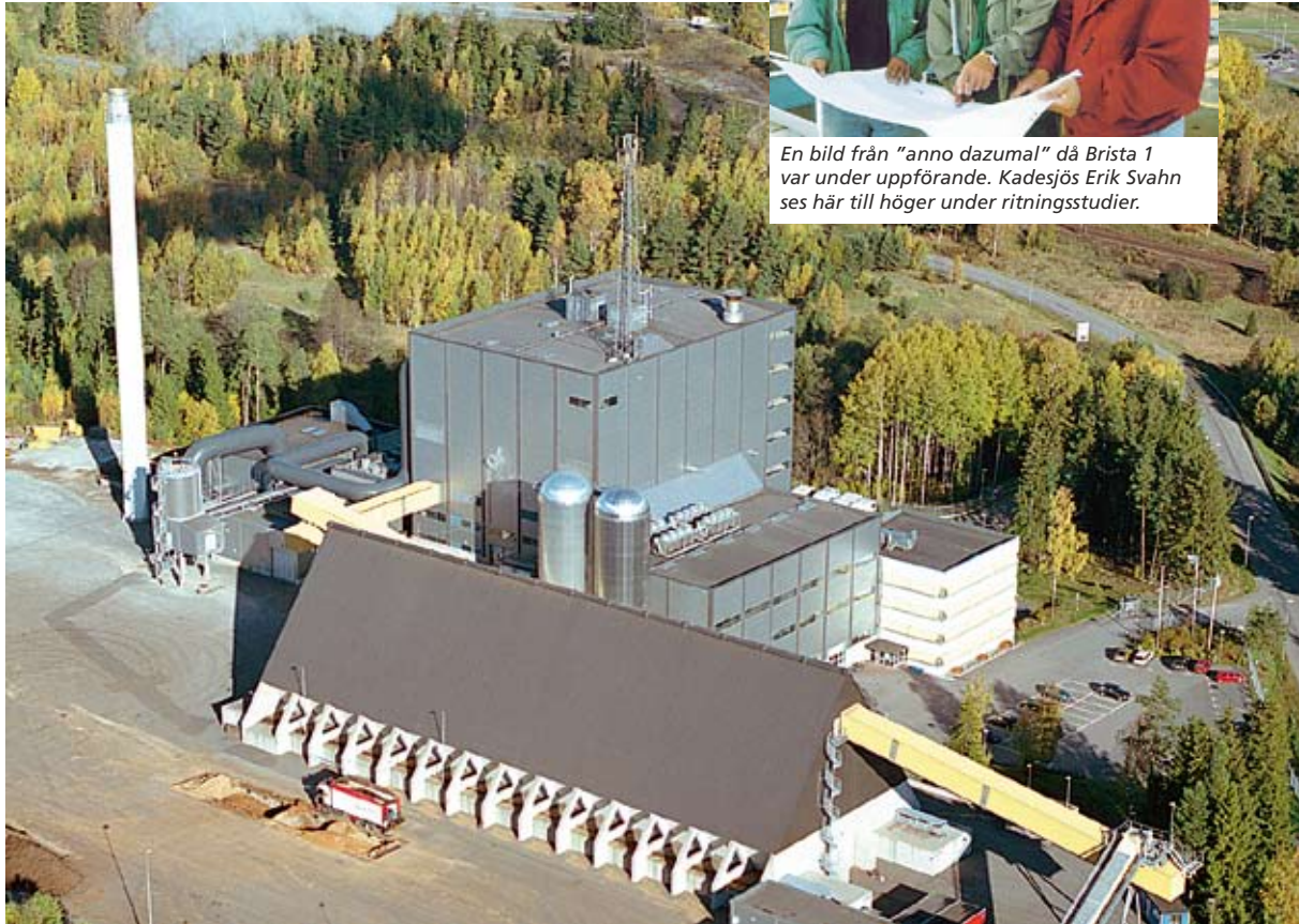
Flygvy över Brista-verket i Sigtuna såsom kraftvärmeanläggningen ser ut i dagsläget.
