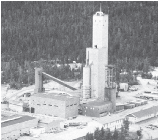
Kadesjös allra första uppdrag 1945 var en kompressorstation för Boliden AB i Laisvall. Så gott som samtliga Bolidens ovanjordsanläggningar kom sedan att projekteras i samarbete med Kadesjös.
