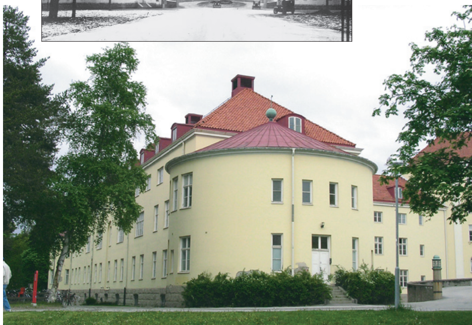
Det gamla lasarettet i Västerås genomgår en pietetsfull renovering och omvandlas till kontor.
