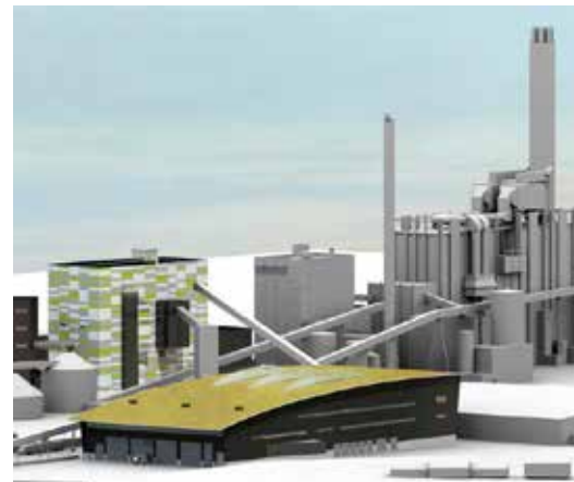
Byggnaden till bränsleberedningen har fått en speciell utformning. Det ska inte synas att det är en avfallshandtering. Här ska avfallet sorteras och beredas till färdigt bränsle. (Visualisering: Scheiwiller Svensson Arkitektkontor).
