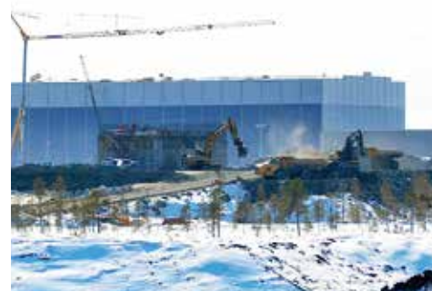
Vy över gruvområdet från avrymning mot anrikningsverket. (Bild från Northland).
