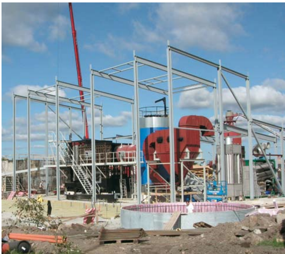
Hällefors Värme bygger en ny fjärrvärmeanläggning på 10 Megawatt och Kadesjös är bygglledare. På bilden har stommen rests och den tekniska utrustningen i full färd med att installeras.
