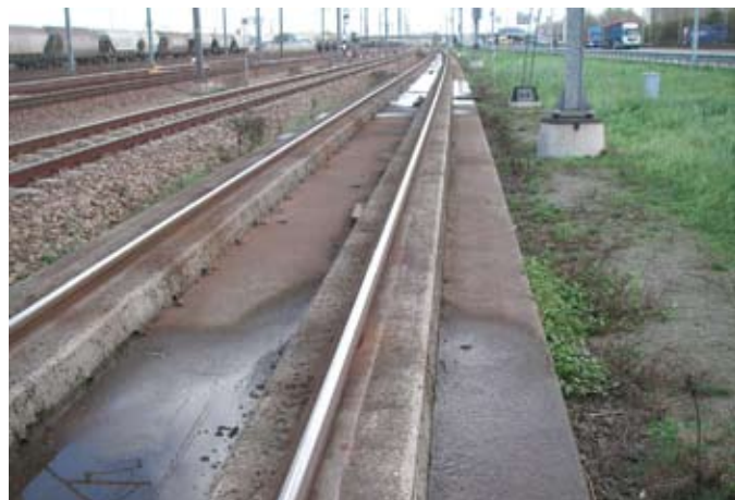
I Rotterdam och Antwerpen används ett justerbart system för att kompensera för sättningarna i järnvägsräls och möjliggöra tågtransporter utan risk.
